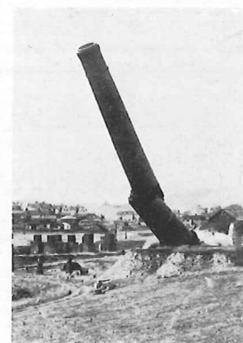
Châta d'une cheminée haute de 63 mètres Bâtisse de Londres.
